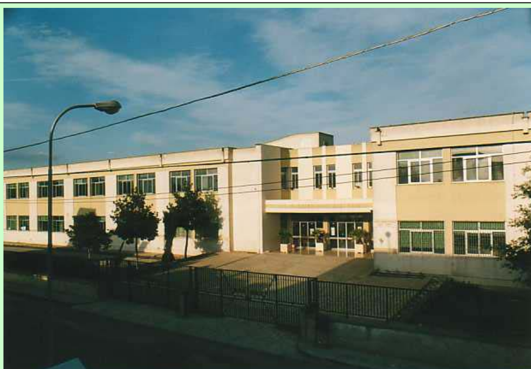
La sede dell'Istituto Comprensivo di Muro Leccese
