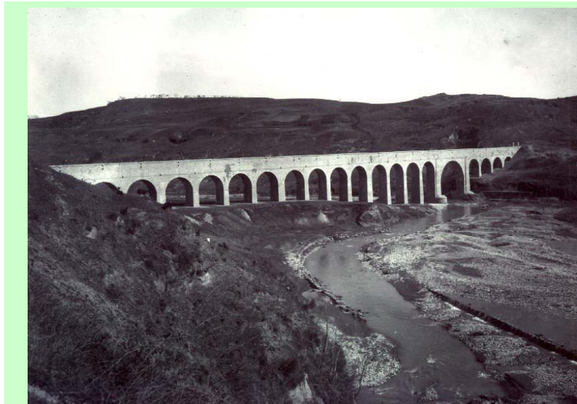
Ponte canale di Atella
