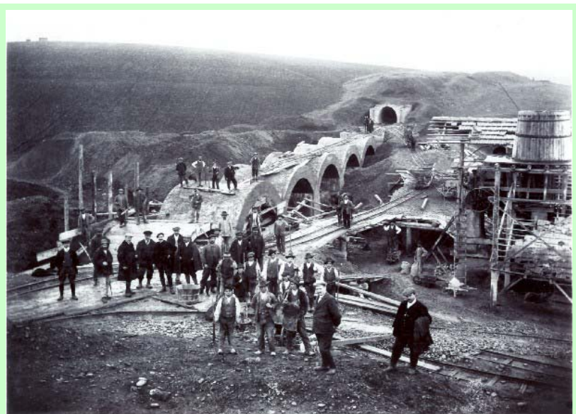
Costruzione del ponte canale del torrente di Atella
